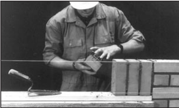
Erst den Mörtel auf den Stein auftragen und dann den LHK/S positionieren.
