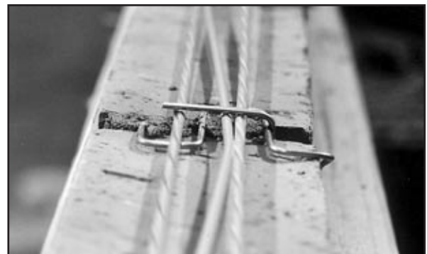
Das Murfor® GER-Element ist verankert im LHK/S.
